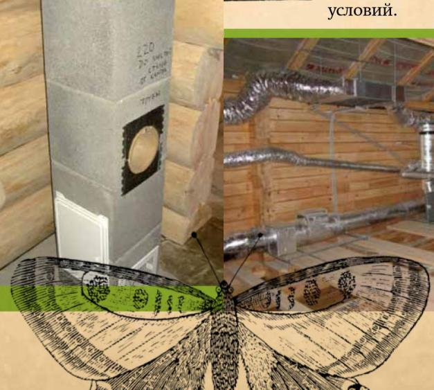
Такая система проста и не требует необходимости в дорогостоящем оборудовании и расходе электроэнергии, но из-за небольшой проходной способности воздуха подходит только для небольших деревянных домов.
